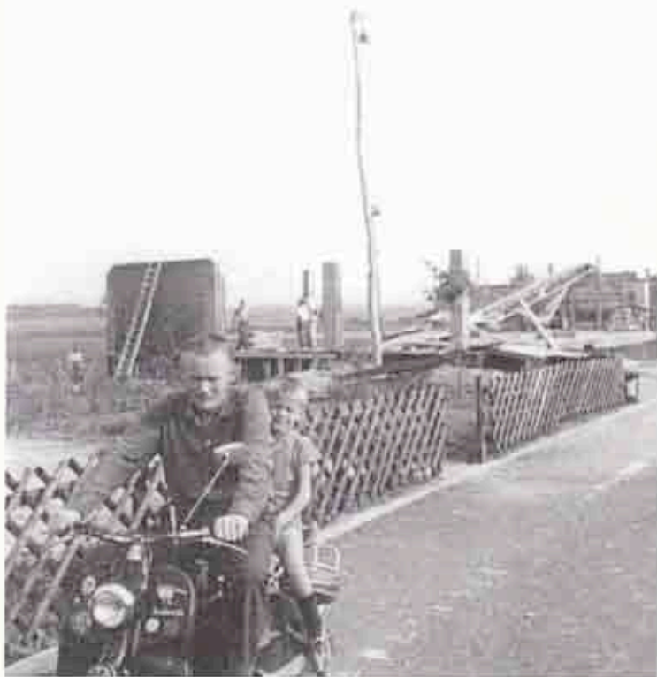
Een bouwplaats in Erlangen Op de voorgrond Frans Roefs met een geleende brommer
